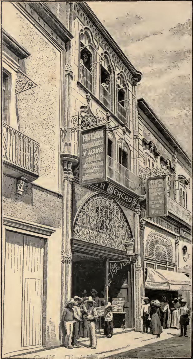
Fachada del Almacén de Drogas y Botica del Mercado—San Luis Potosí, México.
